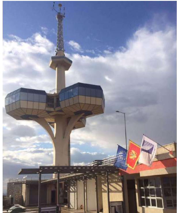
Glavni kontrolno-mjerni centar na Dajbabskoj gori u Podgorici
